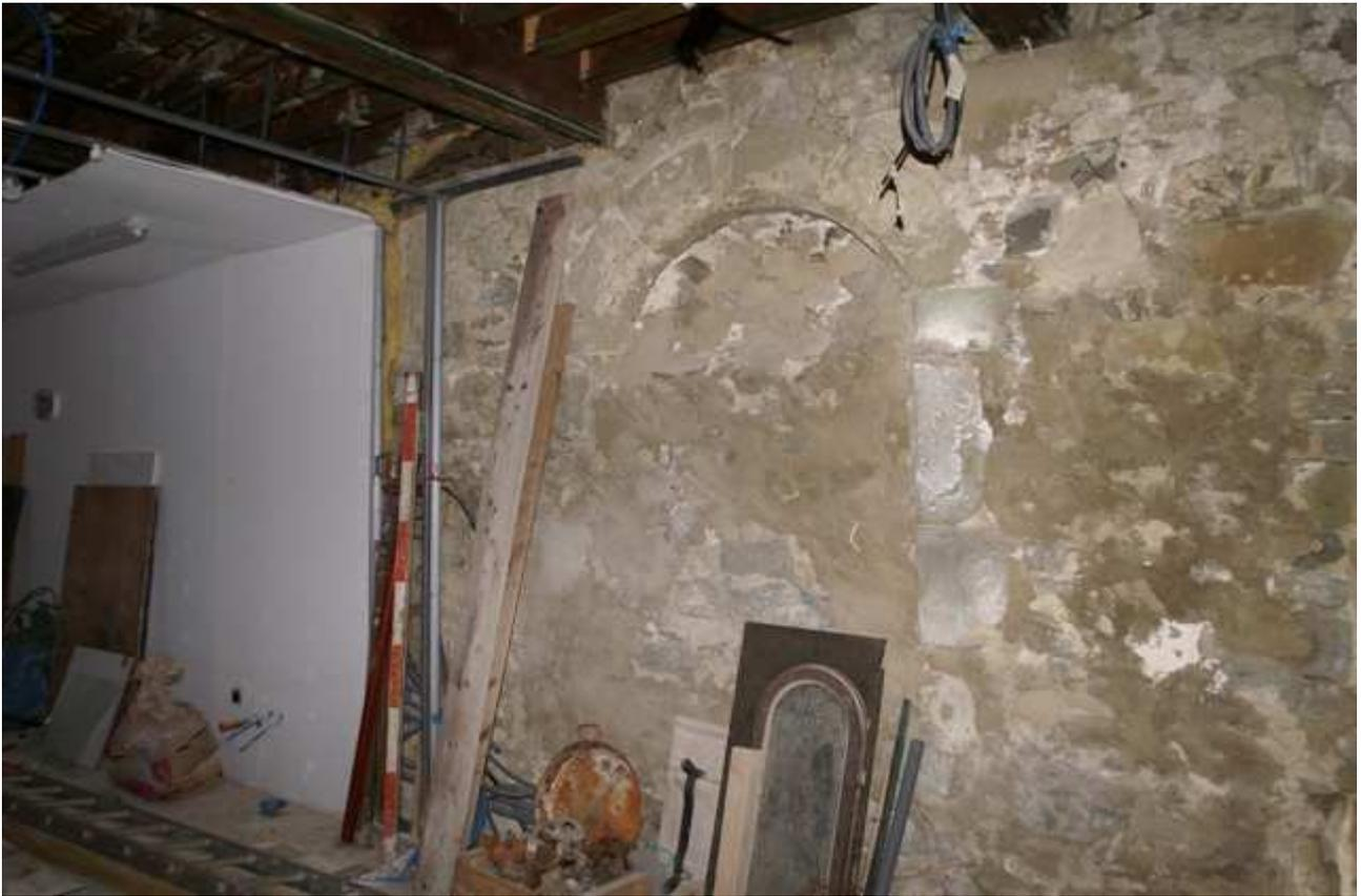
Figure 44: porte murée de la structure B3, dont la face décorée regarde vers le couloir du rez-de-chaussée. Le seuil de cette porte n'est pas en concordance avec celui du logis A et du couloir, ce qui indiquerait que la structure B3 était initialement autonome du logis noble.
