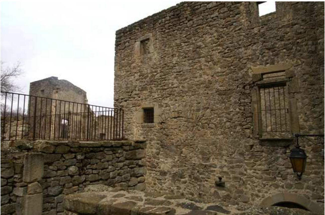
*Figure 36 : logis A, façade sud (« contre mur »). En haut, les fenêtres des « galetas » en demi étage signales en 1796, en dessous la petite fenêtre grillée du cabinet voûté, un arc de décharge correspondant à une ouverture disparue (?), puis l'unique fenêtre de la salle 2.*
