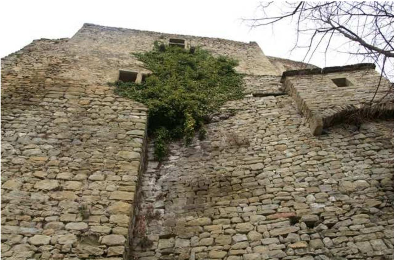
Figure 26 : « tour » à meurtrières C et bretèche E, et vestige de couronnement de mur entre la tour et bretèche : et si l'entrée avait été entre ces deux ouvrages avant le prolongement de la rampe et l'établissement de la barbacane?
