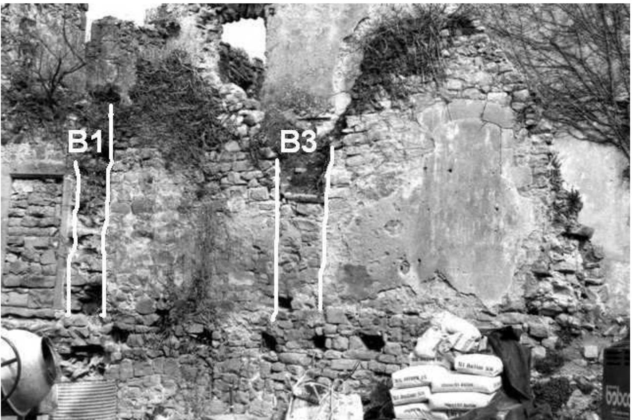
*Figure 45 :à l'étage, porte murée de la structure B5 (à droite) et arrachement bien visibles des murs perpendiculaires des structures B1 et B3 (ADCAVL 1992)*
