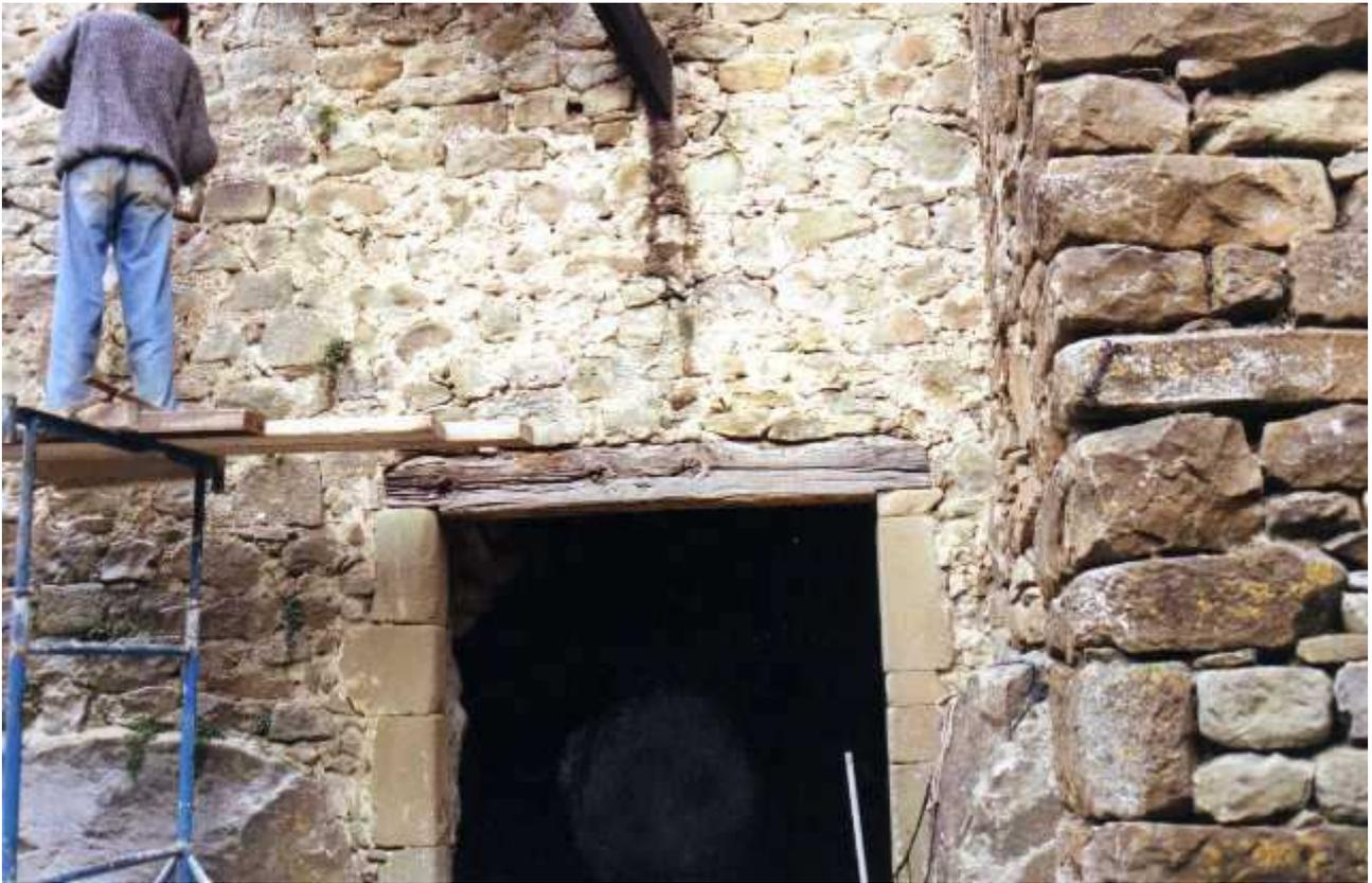
*Figure 28 : état de la porte de salle voûtée du logis A avant remplacement du linteau par un arc en plein cintre.*
