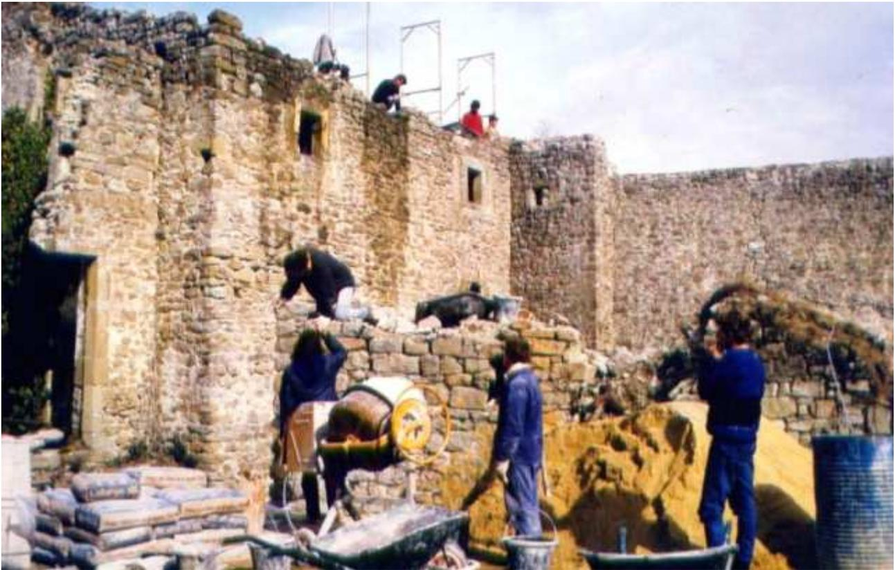
*Figure 37b: vue, sensiblement sous le même angle que la figure 37, montrant le mur du "couloir" en élévation avant son démontage pour raisons de sécurité. On voit que la porte est de même type que celle de la salle voûtée (figure 28) et correspond manifestement à des travaux de "colonisation paysanne" du château au XIXe siècle.*
