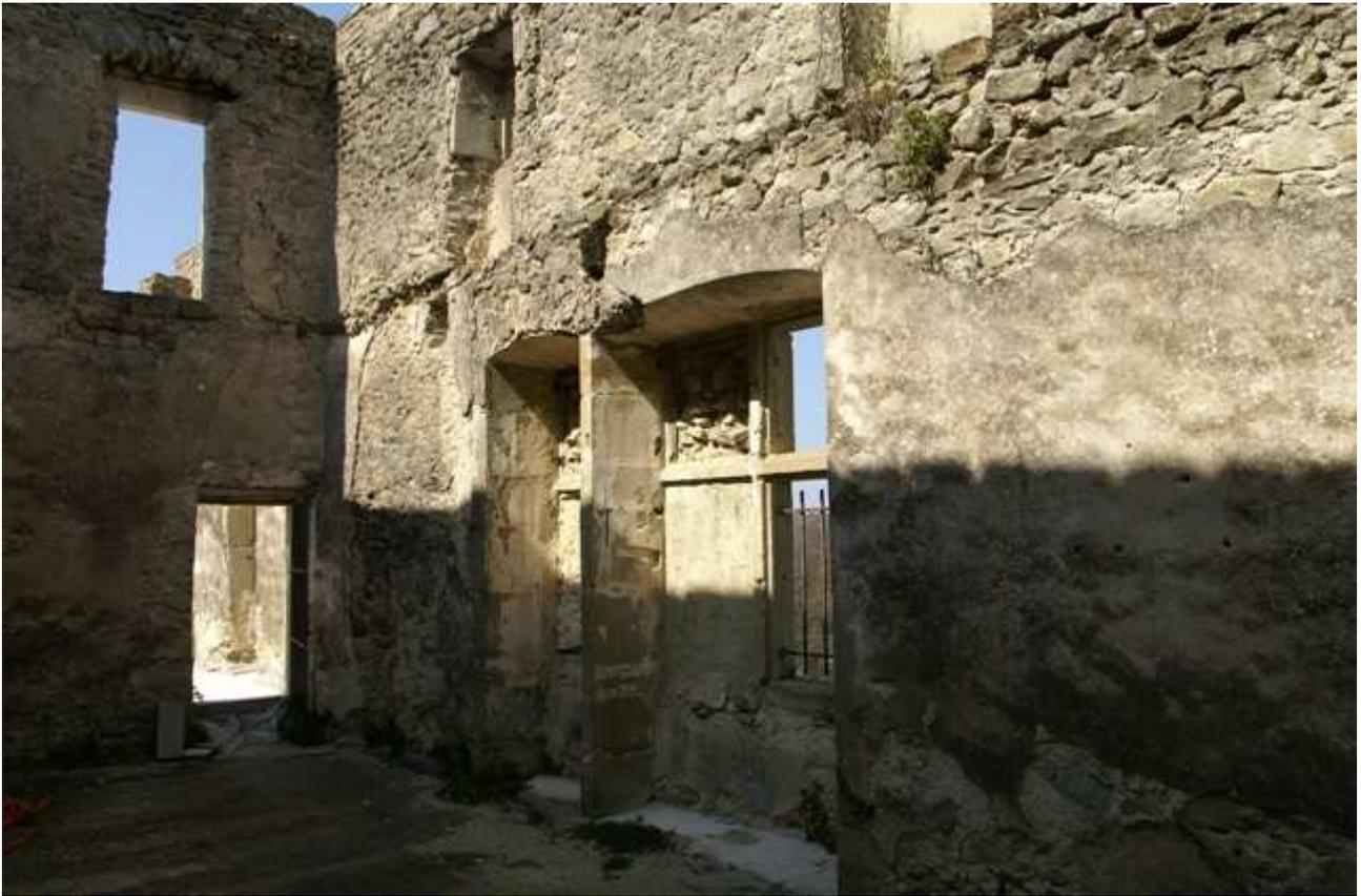
*Figure 31 :salle 1, angle nord-ouest : noter l'exiguïté de la porte, seule communication de cet ensemble de 4 pièces avec le couloir et les logis B et C, par rapport à la dimension et à la qualité des pièces.*
