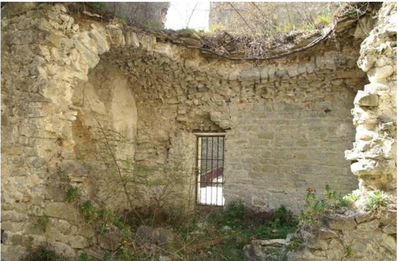
*Figure 34 :salle 2 , le cabinet voûté, en arrière-plan le mur de séparation avec le couloir, en moyen appareil très soigné, correspondant à la face interne est de la "tour"*
