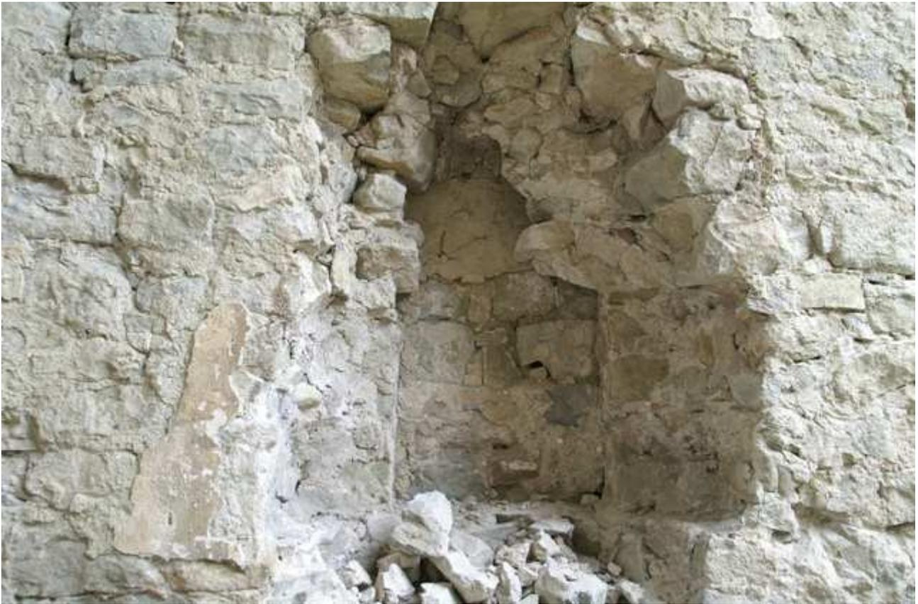
*Figure 69: parement et de l'enduit du mur primitif en fond de niche ménagée dans le mur rapporté*
