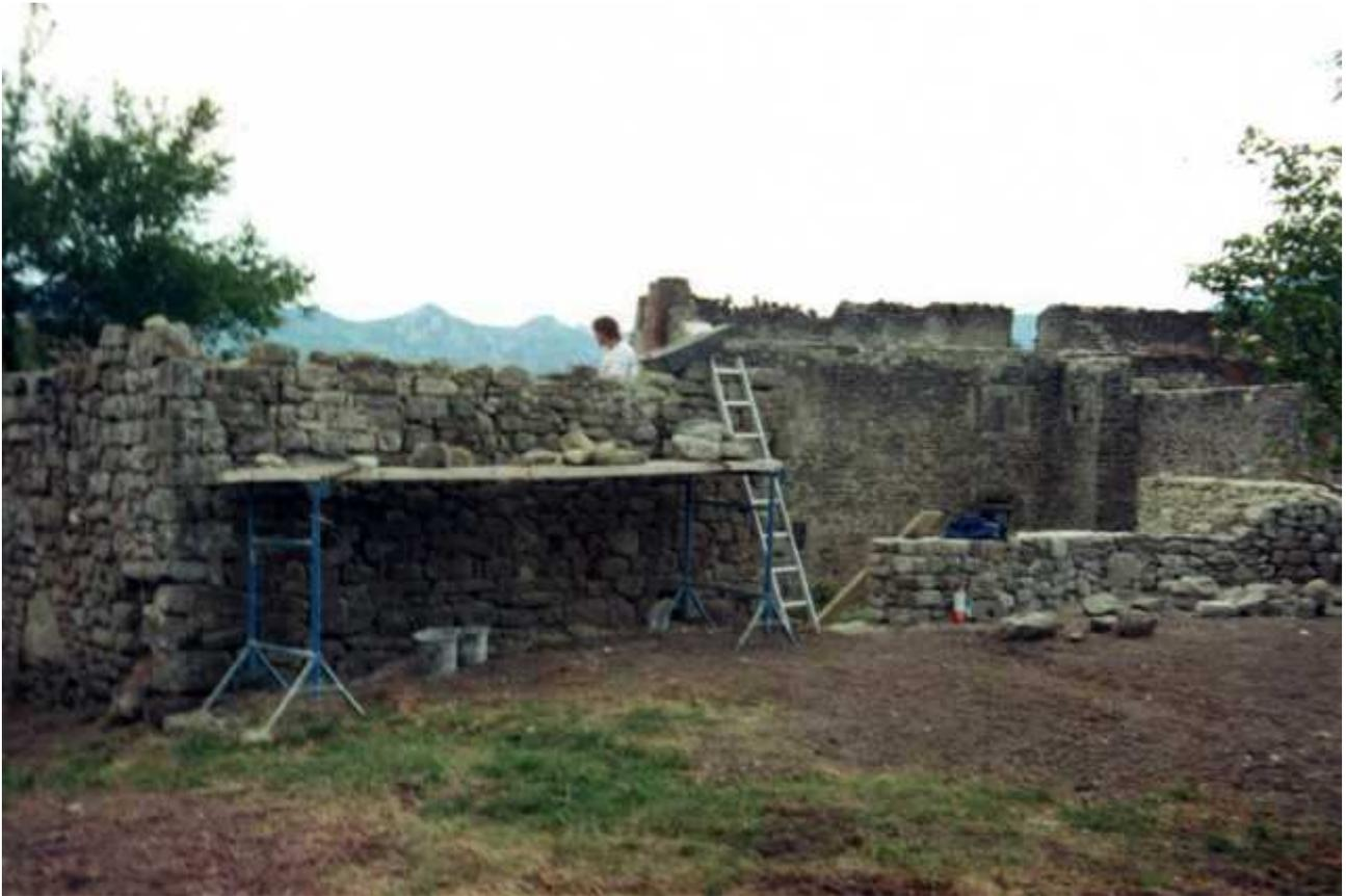
*Figure 79: mur sud du chazal de Pierre Bouvier, retenant la terre du jardin au point culminant du site (cote 121,20 soit 6 mètres au dessus de la plate forme)*
