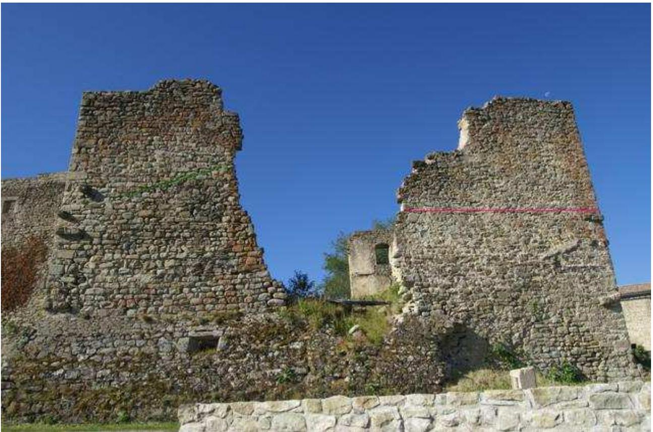
Figure 41b: à droite un niveau d'arrase de mur gouttereau correspondant à la structure C1, à gauche une pente de toiture rattachable à la structure C2
