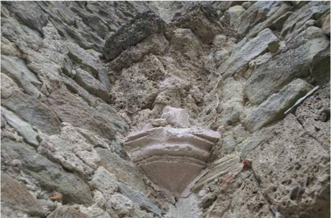
*Figure 58: retombée de voûte stuccuée sur le palier de l'escalier*
