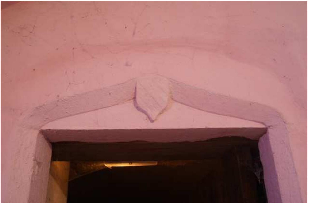
Figure 29b: linteau de la porte blasonnée entre les deux salles voûtées au nord
