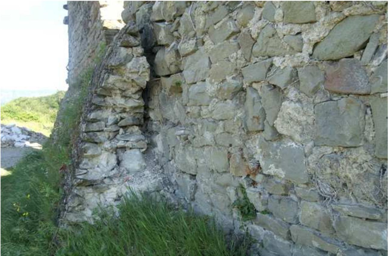
*Figure 60: renfort du soubassement sur façade nord du logis A*
