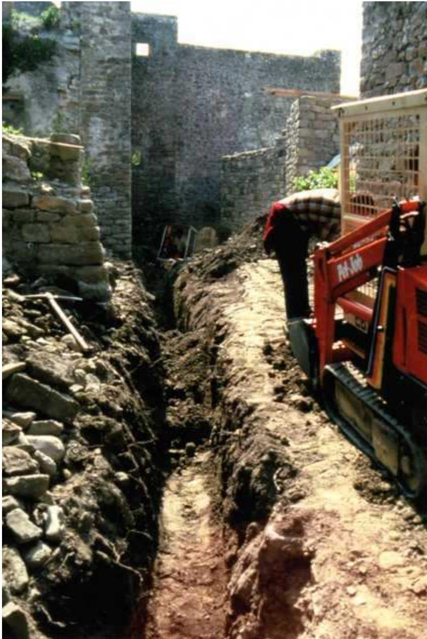
*Figure 53 : lors des travaux préparatoires à l'établissement de la calade par Michel Tillard de l'ADCAVL (vers 1990), on constate que le dos d'âne est un remblai meuble et terreux*
