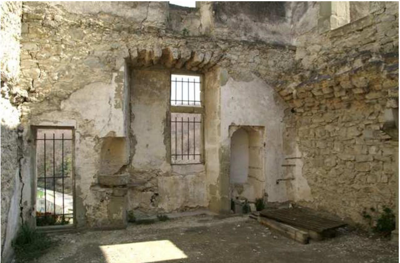
*Figure 32 : cuisine voûtée avec évier à gauche de la fenêtre et à droite dispositif de lavage des textiles et porte de service.*
